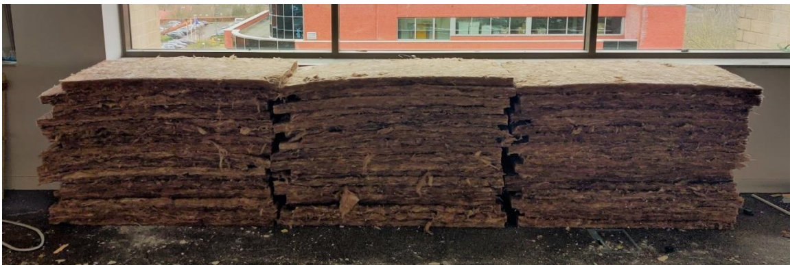
Tijdelijke opslag van platen van minerale wol op een sloopwerf
