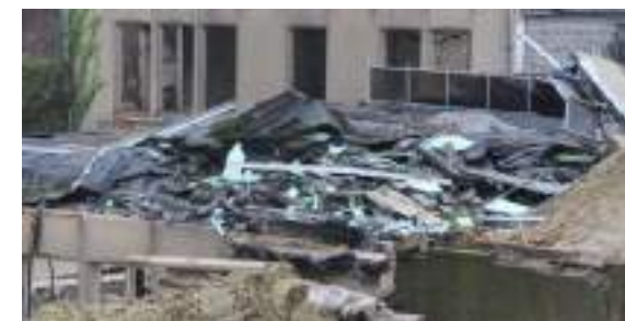
Roofing, isolant, gravats dans le tout venant
