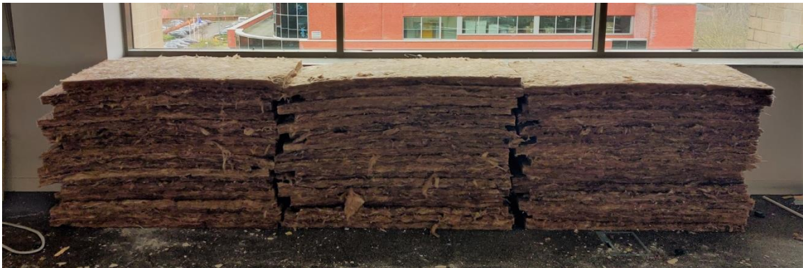
Stockage temporaire de panneaux de laine minérale sur un chantier de déconstruction
