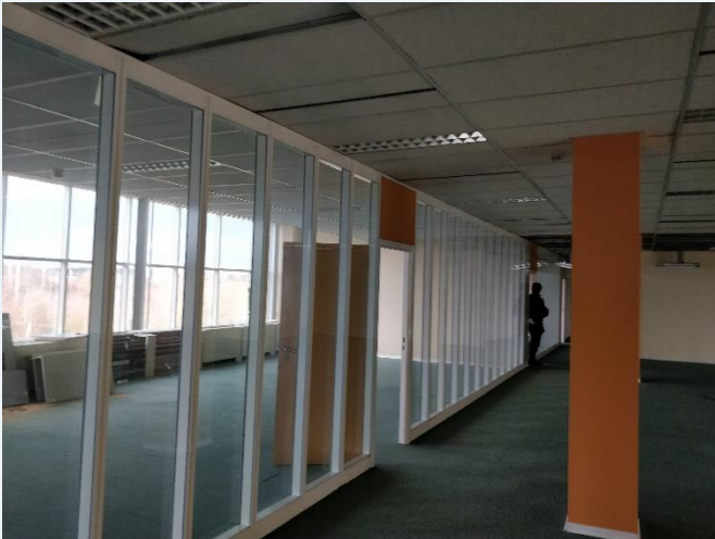
FAL – 180 M 2 CLOISONS VITRÉES ET RACK DATA
