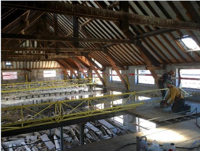
TAP - 10M 3 DE POUTRES EN BOIS
