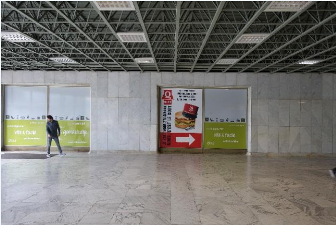
GDN – 150M 2 DE DALLES DE MUR EN MARBRE
